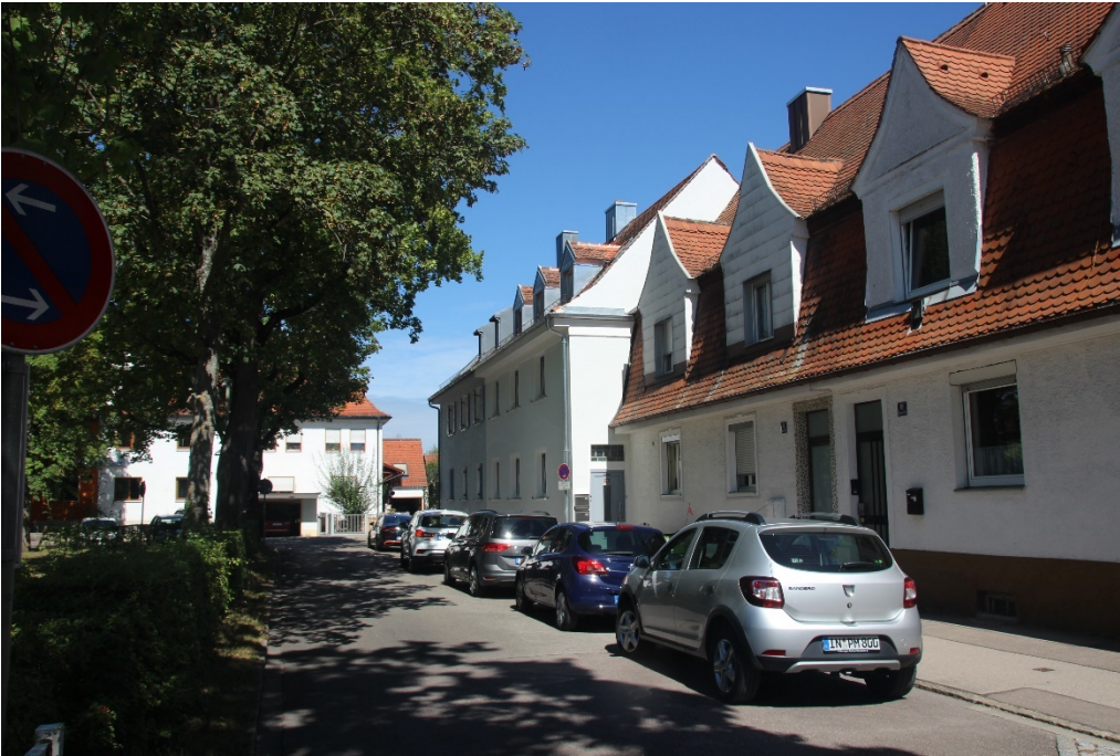
Abbildung 3: Körnerstraße 14, 12, 10, Blick nach Norden
