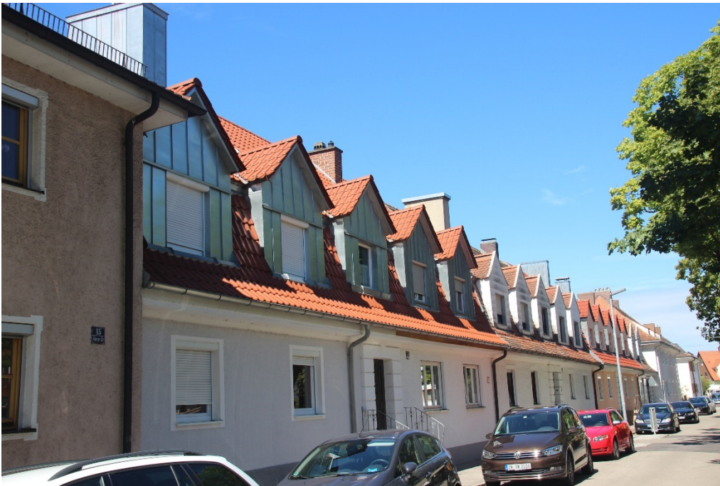
Abbildung 7: Körnerstraße 13 - 5, Blick nach Norden
