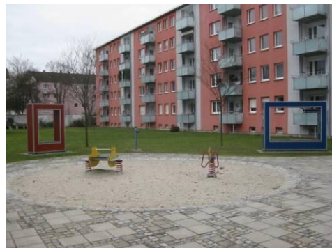
Sanierung Wohngebäude und Wohnumfeldgestaltung Rossinistraße (Südhausbau KG)
