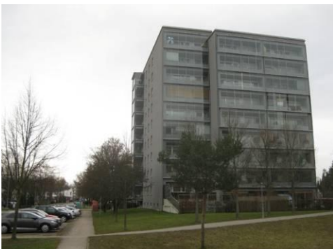
Sanierung Wohngebäude und Wohnumfeldgestaltung Herschelstraße (GWG)
